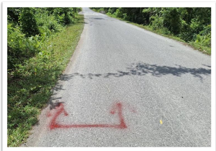
(๑๘) ซ่อมถนนช่วงคอสะพาน
