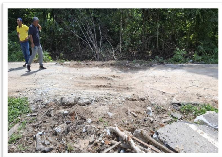
(๑๗) ซ่อมแซมถนนที่ชำรุด หมู่ที่ ๗
